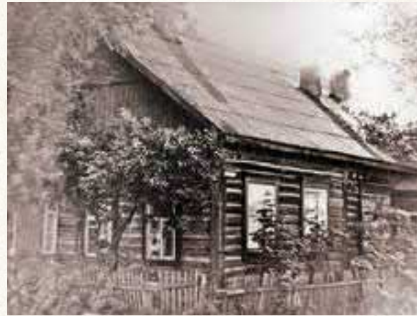
Здание районной СЭС. 1970 год
