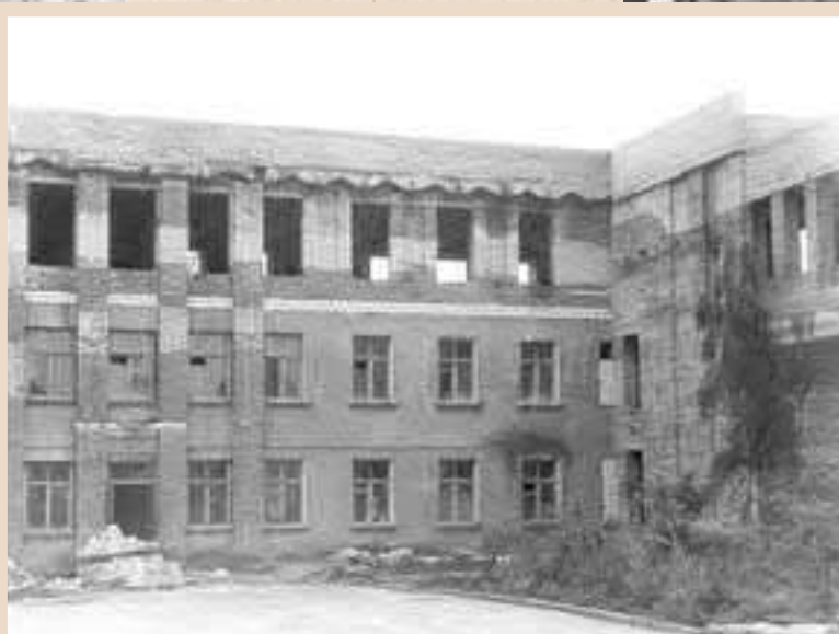
Строительство административного корпуса Гомельской областной СЭС. 1970-е годы
